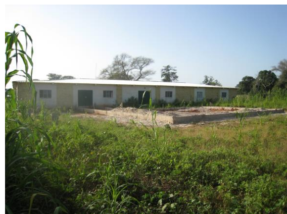
op de binnenplaats is de uitbreiding al op peil
