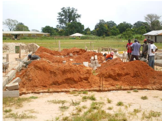
Eind oktober: eerste werkzaamheden aan CEM fase 2
