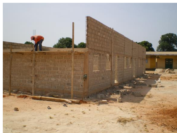
Eind november: de muren staan
